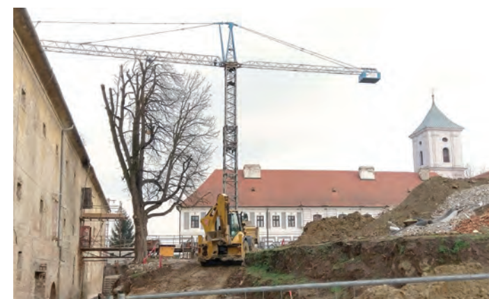
Radovi na obnovi Trga Vatroslava Lisinskog i objekta Stara pekara
